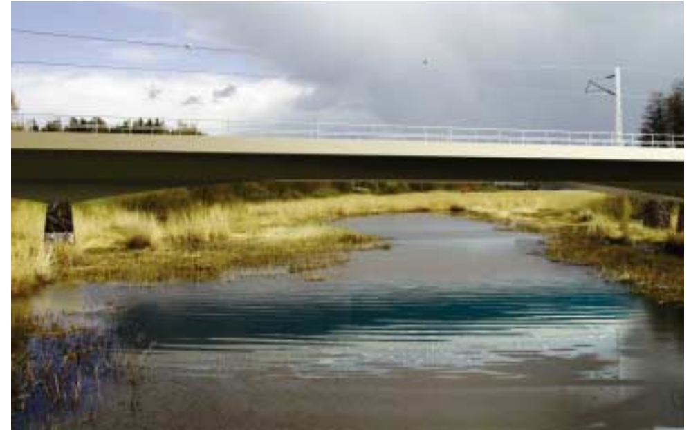
Porvarinlahden sillan pilarit eivät ulotu vesialueelle eivätkä rajoita vesivirtauksia.
