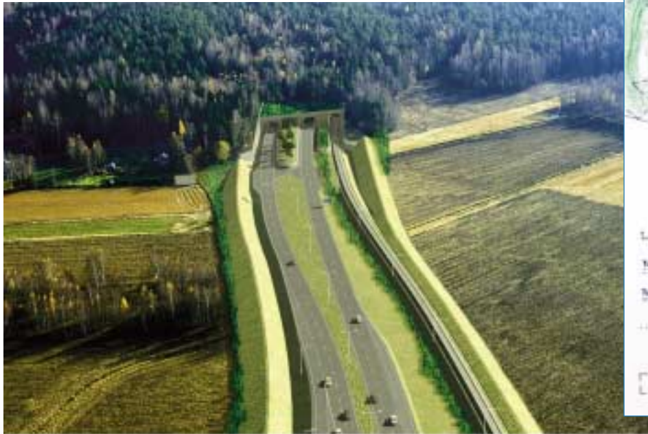
Labbackan pohjoispuolella liikenneväylän molemmin puolin rakennetaan meluvallit.
