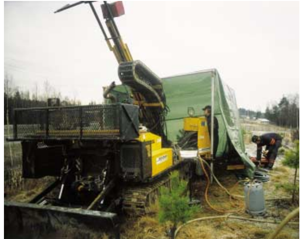
Suunnitellulla tunnelilinjalla kallioperän laadun selvittämiseksi ja pohjavesitutkimuksia varten tehtiin runsaasti koeporauksia.
