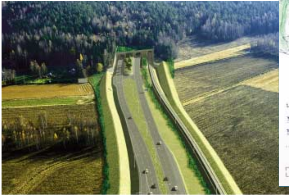
Labbackan pohjoispuolella liikenneväylän molemmin puolin rakennetaan meluvallit.
